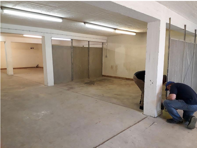
Hier werden gerade die Einbauten der ehemaligen Kleiderkammer ausgebaut.
